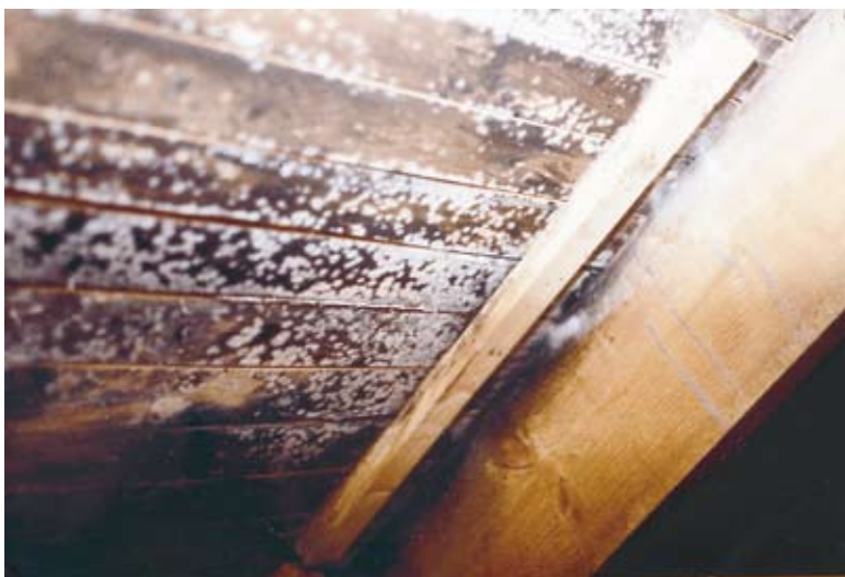
Figur 2. Kraftig påväxt på råspont. Men riklig förekomst av mögel är inte alltid synlig för blotta ögat.
